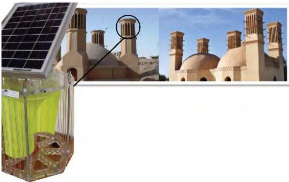
شکل ۵- مدل‌سازی بادگیر خورشیدی با الهام از بادگیر سنتی باغ دولت آباد یزد
